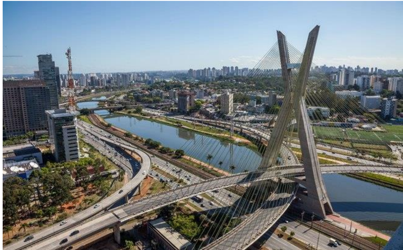
ponte Octavio Frias de Oliveira – São Paulo
